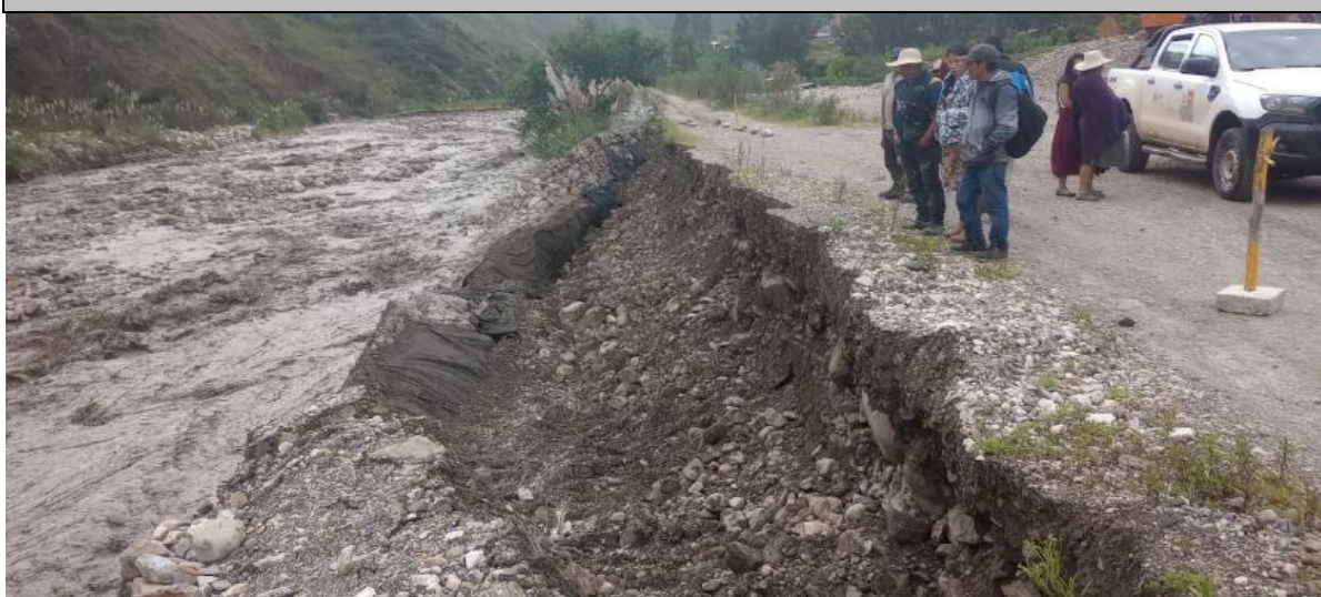
FIGURA N°01: RECORRIDO E IDENTIFICACION DE TRAMOS CRÍTICOS DESDE EL PUNTO DE INICIO, DONDE SE PUEDE VISUALIZAR QUE EL RIO EN SU MAREGEN DERECHA AFECTADO A VIVIENDAS Y PARTE DE LA CARRETERA DESTRUIDA.
